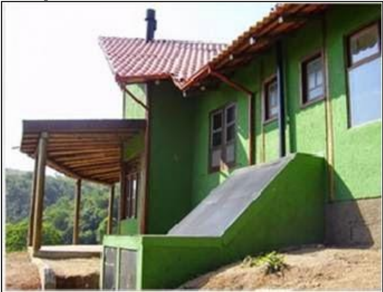
Figura 73 – Fundo de um banheiro seco instalado no interior do domicílio
