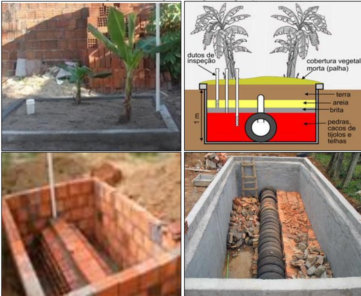
Figura 69 – Tanque de evapotranspiração
