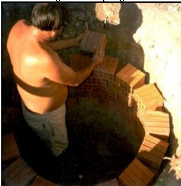
Figura 65 - Tipologia de sumidouro: sumidouro de tijolo
