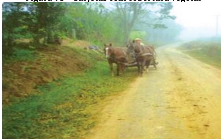
Figura 93 - Sarjetas com cobertura vegetal
