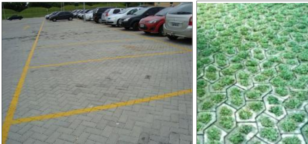
Figura 89 – Exemplos de pavimento drenante
