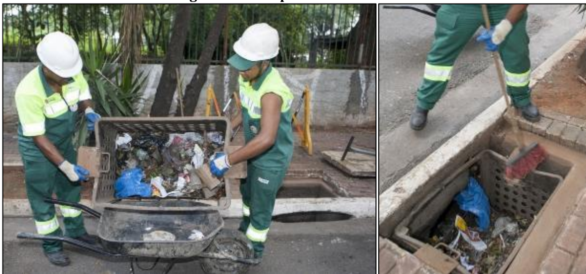
Figura 82 – Limpeza de boca de lobo
