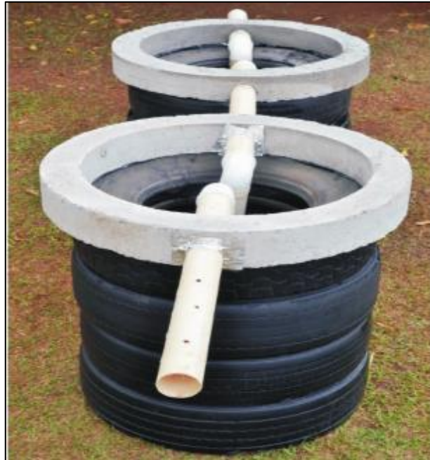
Figura 62 - Fossas sustentáveis construídas pela DMAE
