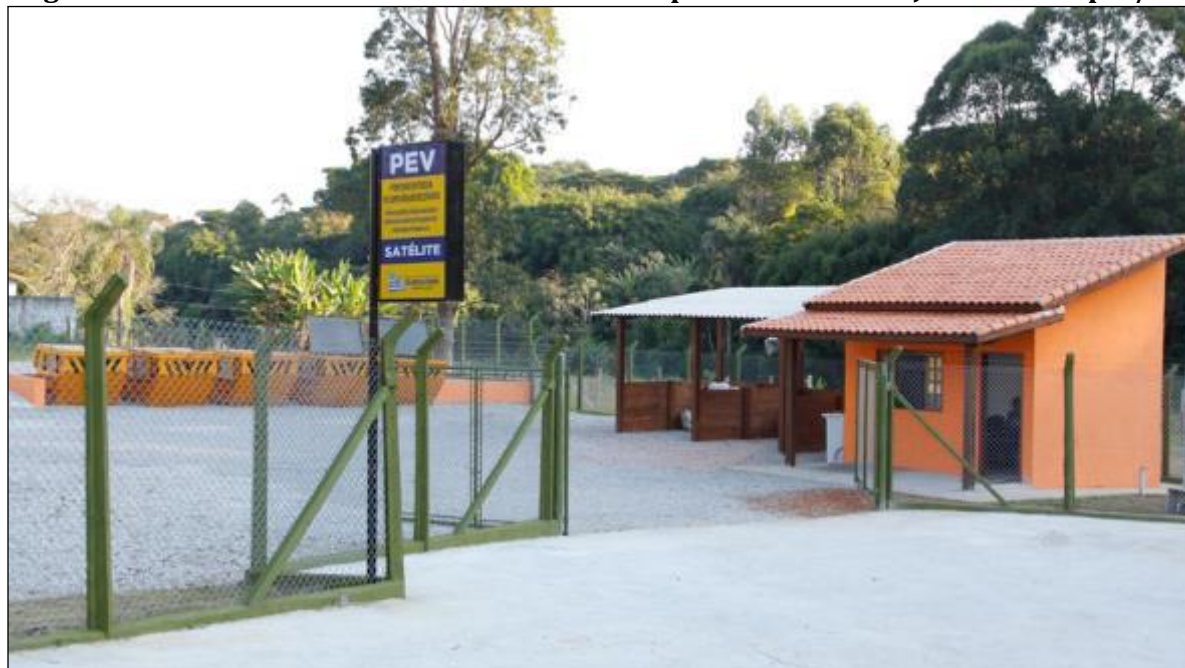
Figura 162 – Vista da fachada de um dos PEVs implantados em São José dos Campos/SP
