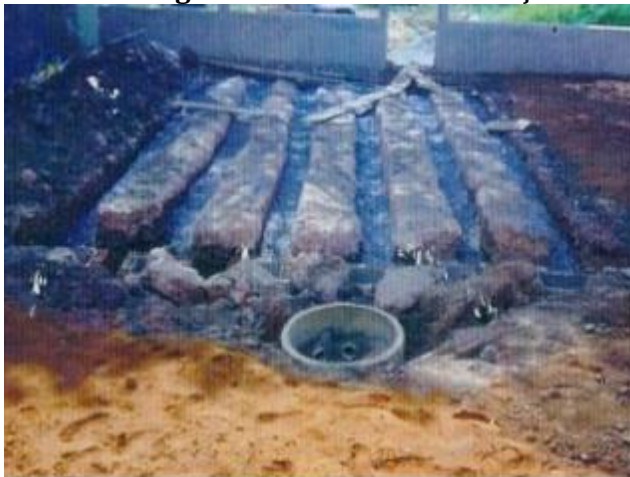
Figura 64 - Valas de infiltração construídas e esquema do leito filtrante
