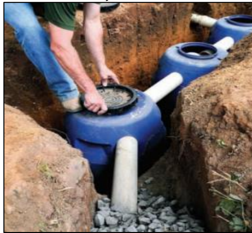
Figura 60 – Instalação das fossas econômicas
