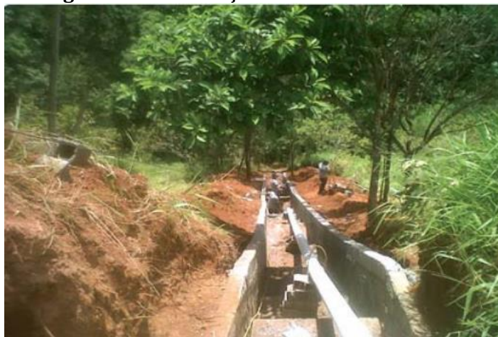
Figura 96 - Construção de escada hidráulica
