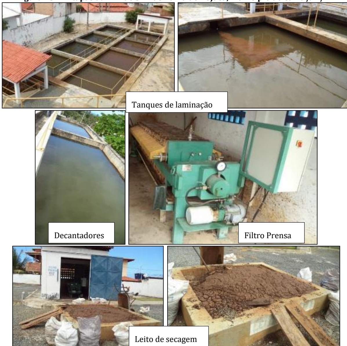
Figura 154 - Etapas da ETL do SAA de Barra do Pojuca, município de Camaçari/BA
