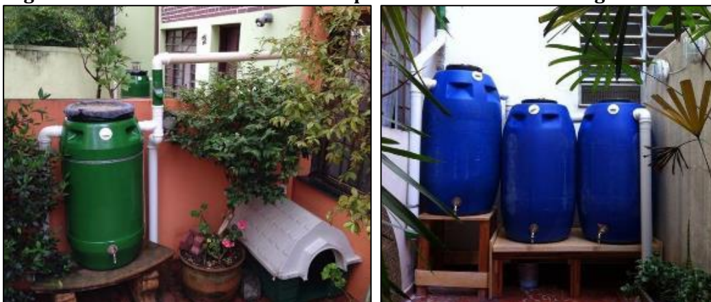
Figura 85 - Reservatórios domésticos para armazenamento de água de chuva
