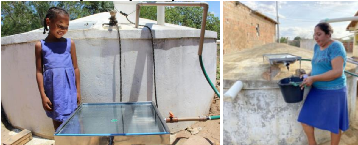
Figura 40 – Dispositivo Aqualuz instalado em cisternas
