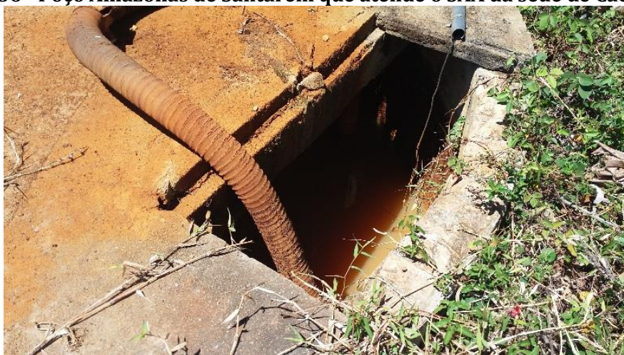
Figura 36 - Poço Amazonas de Santarém que atende o SAA da sede de Caetité/BA.
