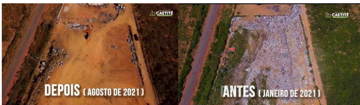
Figura 137 – Transformação do Vazadouro a Céu Aberto da sede municipal em Aterro Controlado
