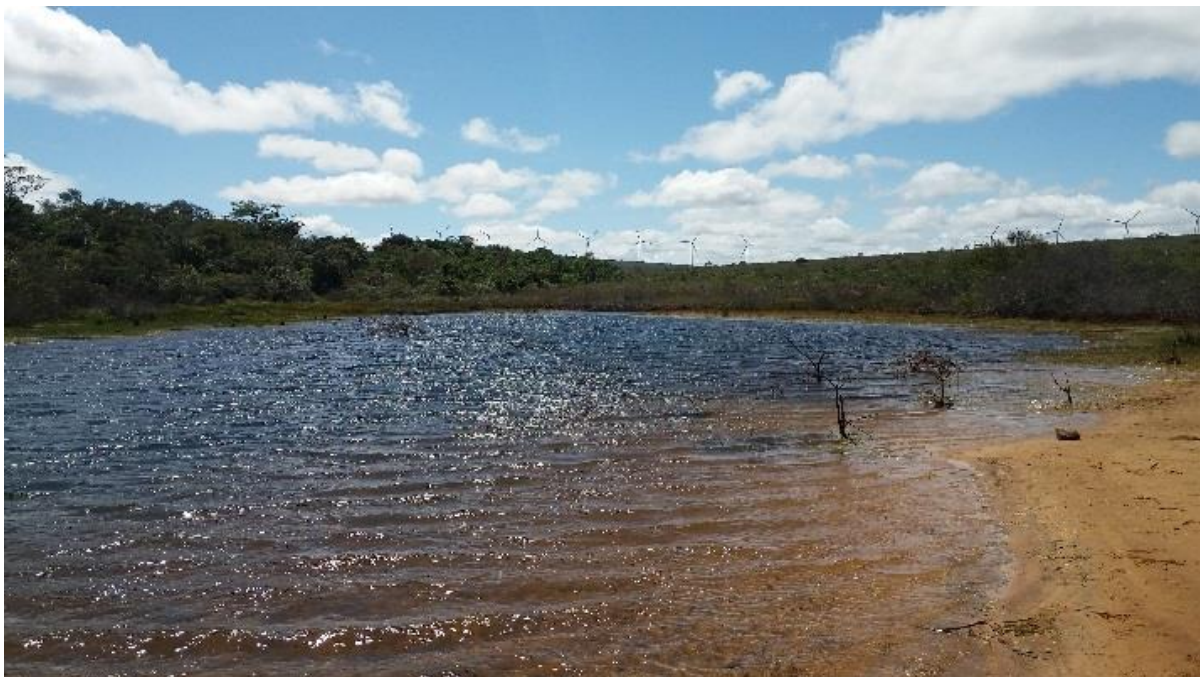
Figura 32 – Barragem de Passagem das Pedras que atende o SAA da sede de Caetité/BA.
