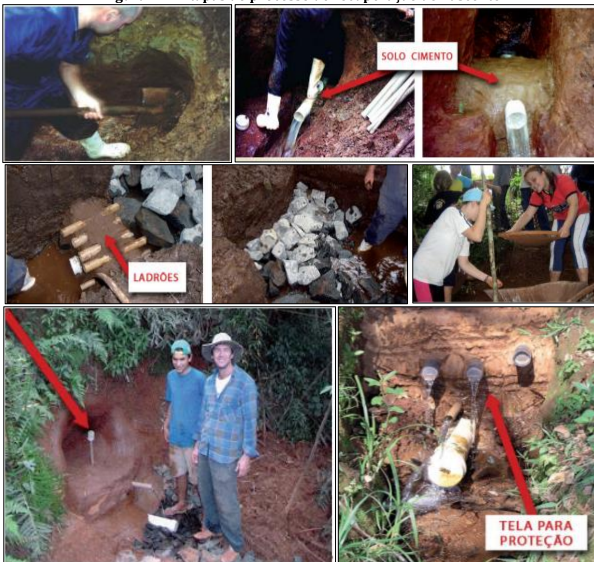
Figura 41 – Etapas do processo de recuperação de nascente
