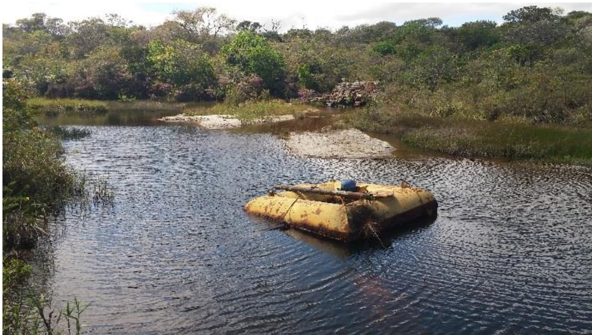
Figura 33 – Barragem de Moita dos Porcos que atende o SAA da sede de Caetité/BA
