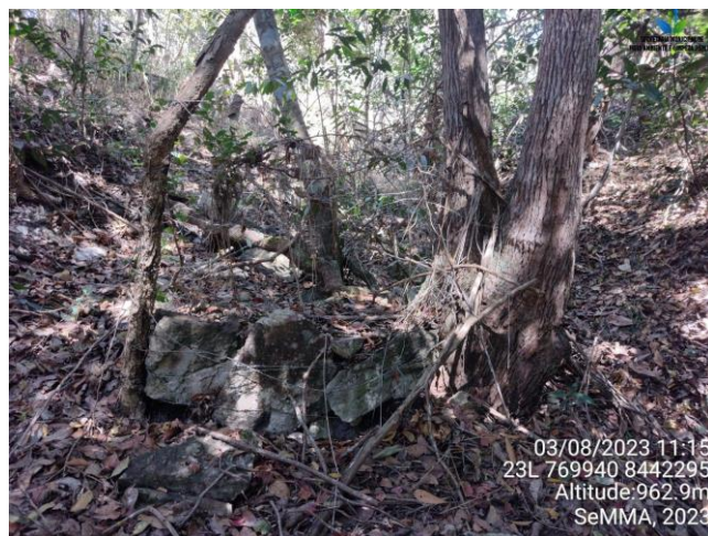
Imagem 15: Cercamento e construção de alvenaria onde a nascente aflorava há anos atrás.
