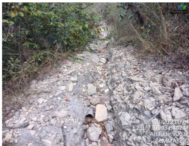
Imagem 21: Erosão na trilha, próximo à APP da Nascente do Riacho Pedreira.
